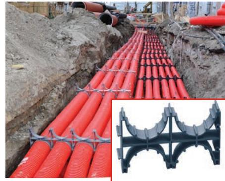
**Рис.1** Применение кластеров для многоуровневой кабельной канализации.
