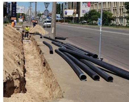
При укладке и монтаже кабелепроводов необходимо следить за тем, чтобы не произошло засорение каналов труб. С этой целью все свободные концы труб должны быть плотно закрыты заглушками (при необходимости обеспечения герметичности трубопровода используются заглушки с уплотнительным кольцом) (рис. 2). При перерыве в работе более 1 суток траншеи следует защищать от затопления водой.
